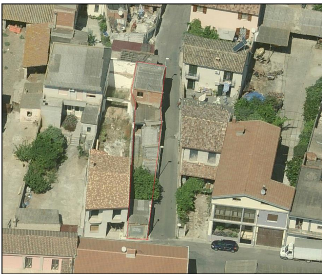
Figura numero 03. Vista aerea del fabbricato da demolire e acquisire per la viabilità comunale.
